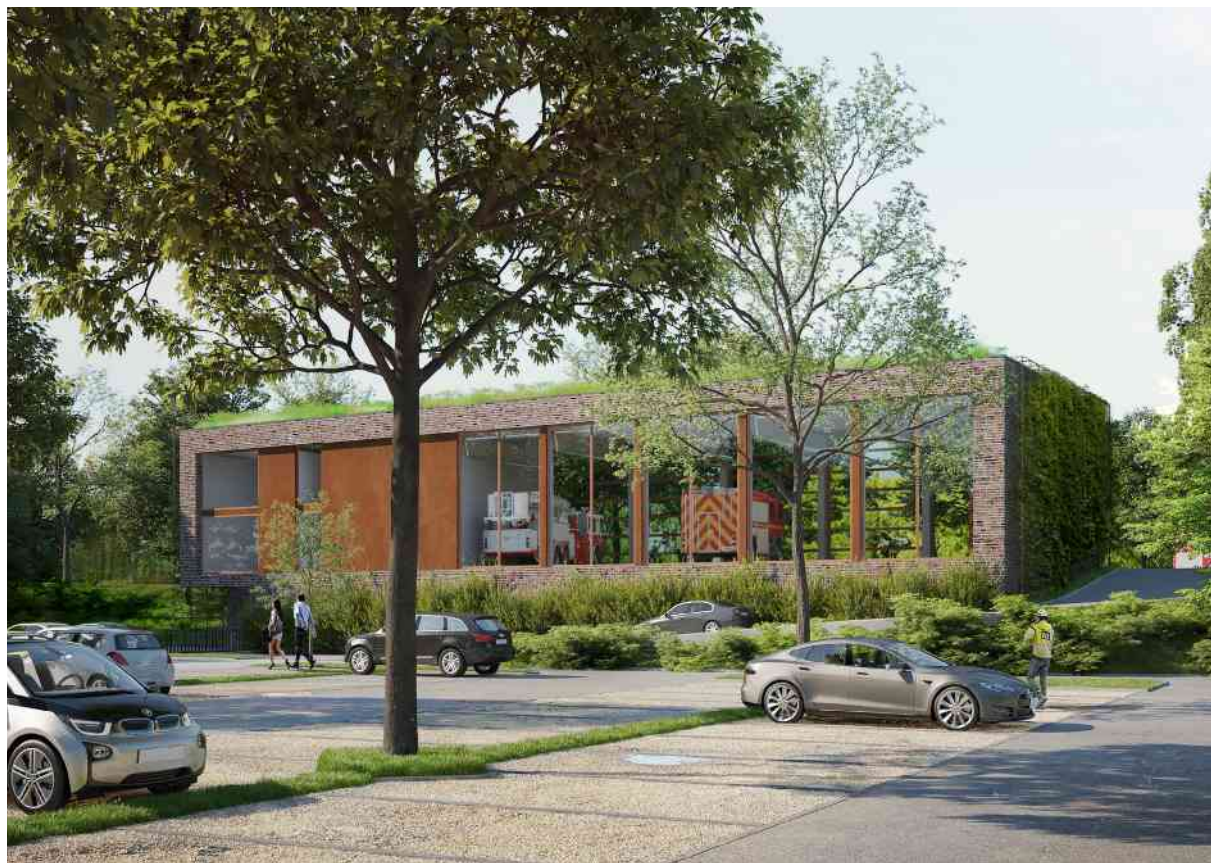
Abbildung 14: Nord- und Südansicht der Feuerwache Kaiserswerth in Düsseldorf
