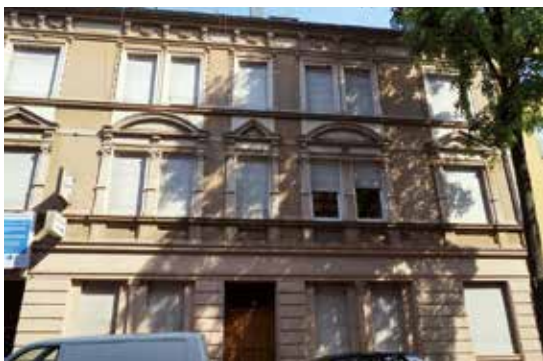
Abb. 5: Gebäude vor der Sanierung 56
