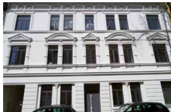
Abb. 6: Gebäude nach der Sanierung 57
