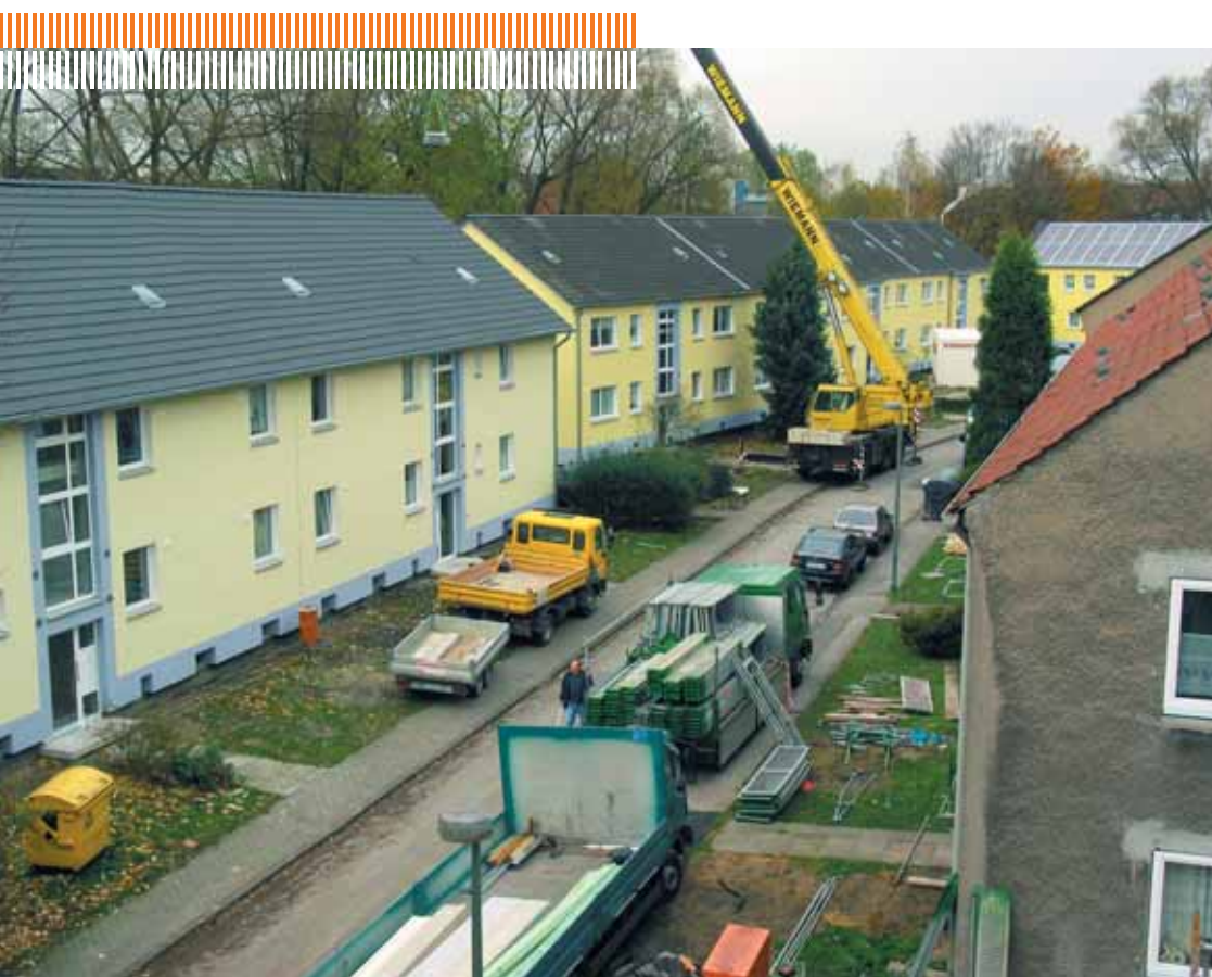
Blick in den Timpenkamp während der Modernisierungsarbeiten (November 2002)
