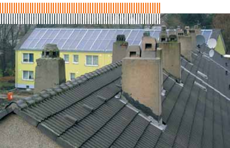
Alt und Neu im Lindenhof nebeneinander: bereits im September 2002 wurde das erste Gebäude fertiggestellt.
