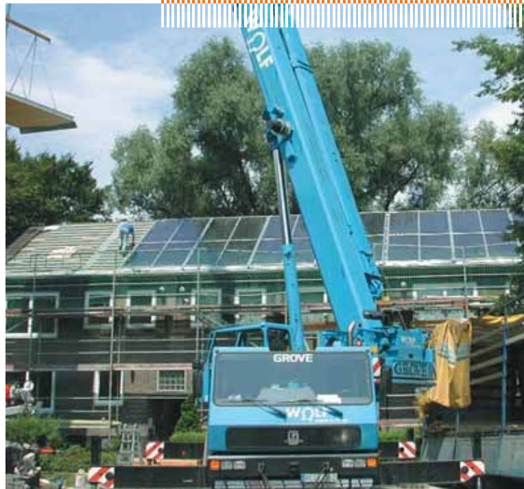
Die ersten Solarkollektoren wurden am 9. Juli 2002 montiert
