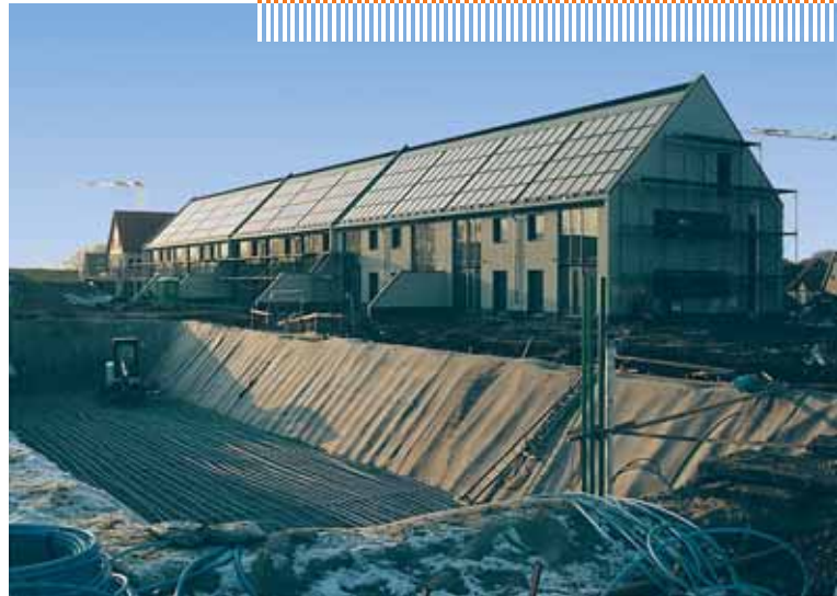
Langzeit-Wärmespeicher in der Bauphase
